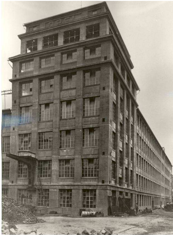
31 Gebäude des ersten Fließbandes (A9), das bis auf den Turm abgerissen werden soll.
