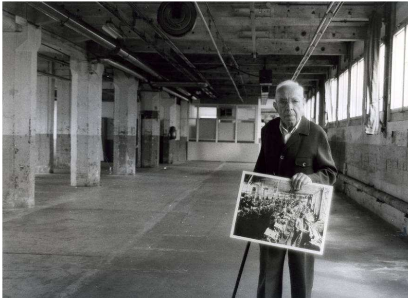
33 Georg Hüter im Alter von 93 Jahren im Gebäude des ersten Fließbandes.
