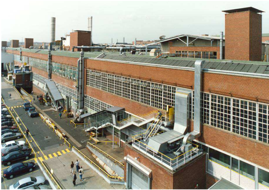
21 Fabrikbau K 40, erbaut 1951-58.
